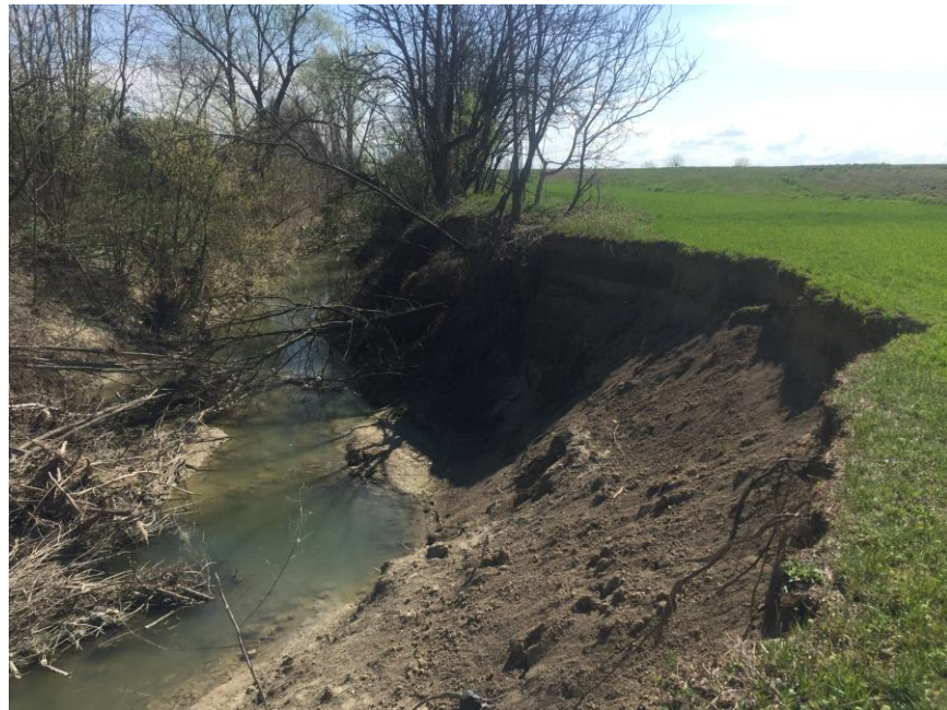
Vista di movimento franoso per erosione al piede del torrente Arda (Intervento A)
